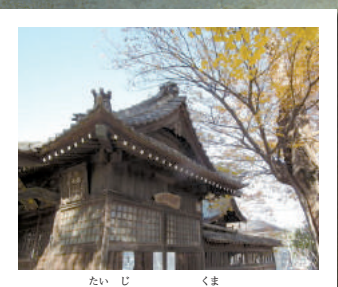
退治した熊が祀られている千形神社 (埼玉県熊谷市本町1-18)
